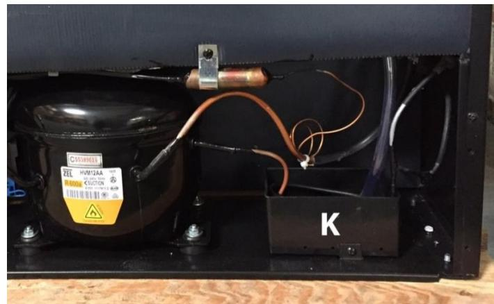
Rimuovere con una spugna eventualmente l'acqua di condensa dal contenitore di raccolta della condensa. Questo si trova sul retro dell'apparecchio in basso a destra. A tale scopo rimuovere la copertura di metallo e poi riavvitarla.
